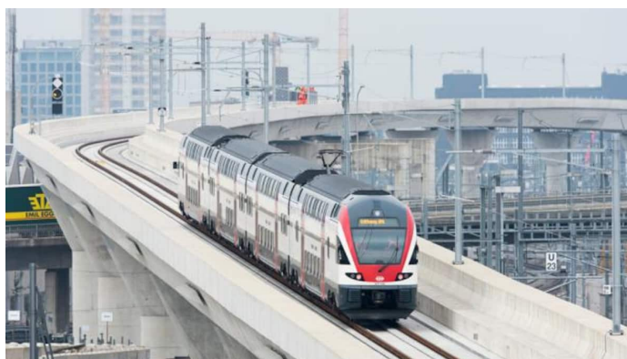
Abbildung 20: Beispiel für ein Überwerfungsbauwerk ( https://www.handelszeitung.ch/beruf/bildergalerie/infrastruktur-die-durchmesserlinie-ist-komplett ; https://www.10zu8.ch/projekte/mehrspur-zuerich-winterthur/ )
