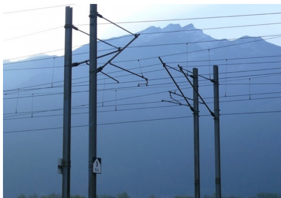
Abbildung 7: links: Stahlmast (Quelle: https://www.bahnbilder.de )
