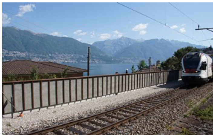
Abbildung 14: Beispiel einer Lärmschutzwand (Quelle: BAV)
